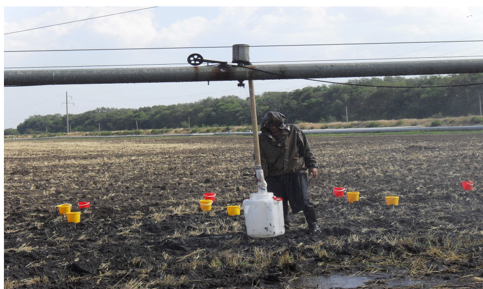
Рисунок 3.2 – Замер расхода воды дефлекторной насадки объемным методом.
