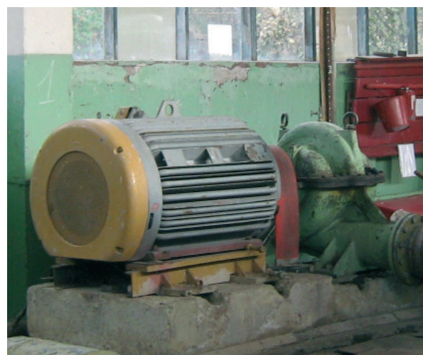
Рис. 2. Электродвигатель MEZ brno 1N4 355 Y-4
