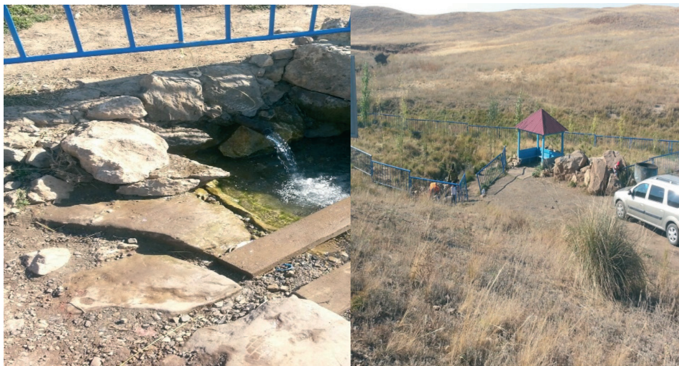
Рис. 2. Каптаж и благоустройство родника Исламбулак
