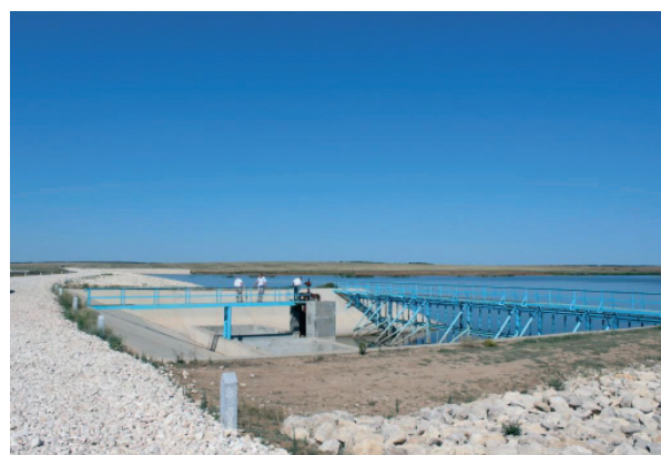
Рис. 2. Строительство Большеузенского водохранилища на р. Большой Узень (Ершовский район)
