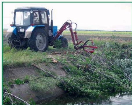
Срезка древесно-кустарниковой растительности на откосах кусторезом КН-3(СГАУ)
