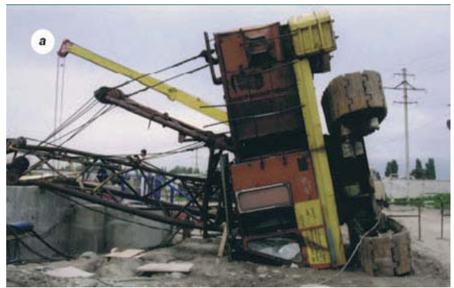
Рис. 8. Авария гусеничного грузоподъемного крана в результате опрокидывания
