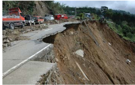
Промоины на дороге при сходе снега или дождевой- воды
