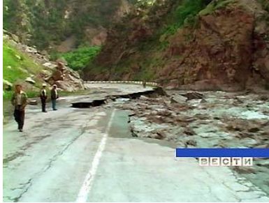
Промоины на дороге при сходе снега или дождевой- воды
