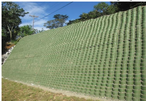
Рис. 17 Подпорная стенка, армированная георешетками [12]
