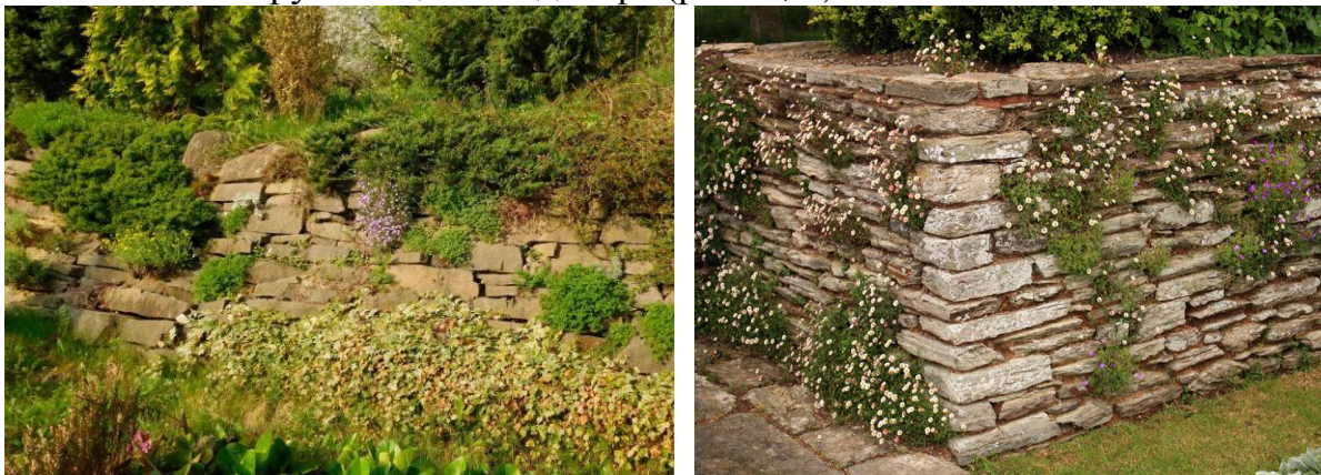
Рис. 2,3 Примеры каменных подпорных стенок методом сухой кладки [2, 10]
