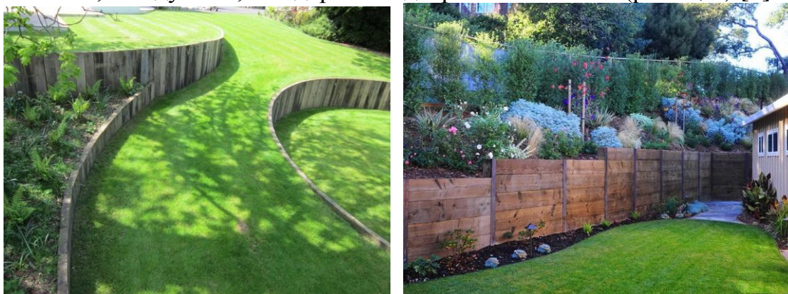
Рис. 6,7 Примеры устройства подпорных стенок из дерева [7]
