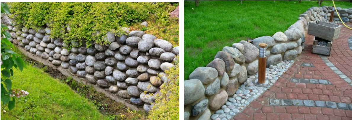
Рис. 4, 5 Варианты подпорной стенки на цементном растворе [11]
