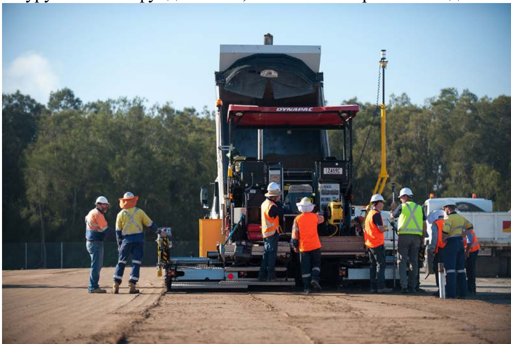
Рисунок 2 – Система Screeed Pro на асфальтоукладчике.
