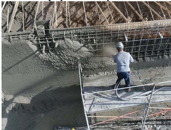
Рисунок 3 – Торкретирование.
