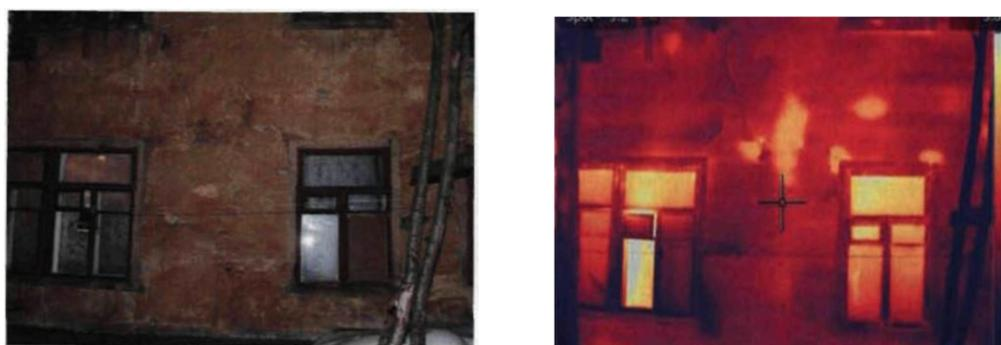
Рисунок 1. Обследование здания с помощью тепловизора
