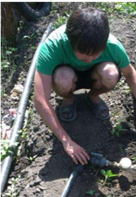
Монтаж системы капельного орошения
