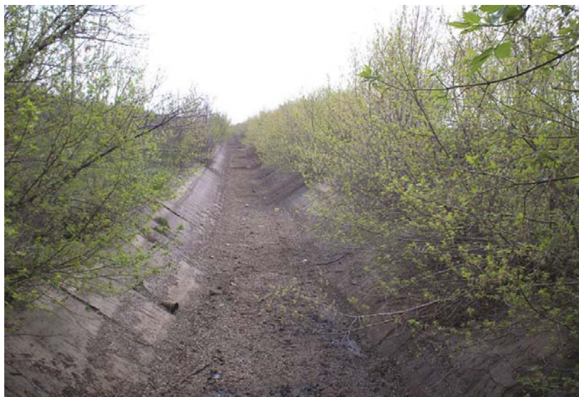
Рисунок 1.5 – Заросший древесно-кустарниковой растительностью и заиленный участок оросительного канала
