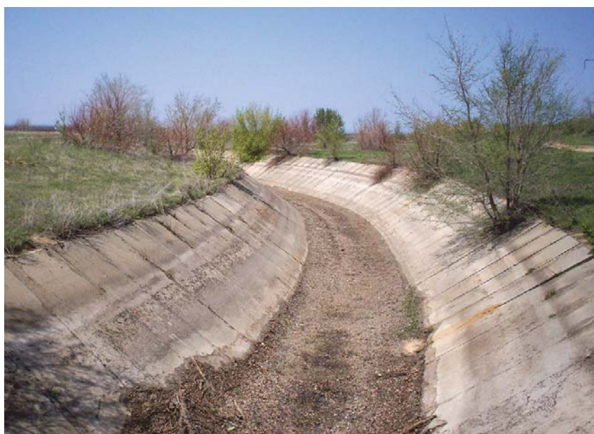
Рисунок 1.6 – Участок оросительного канала, засоренный донными отложениями
