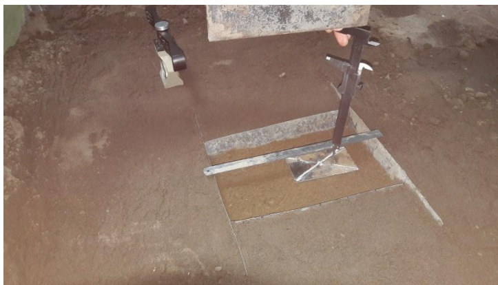
Рисунок 3.18 – Замер глубины погружения металлического штампа
