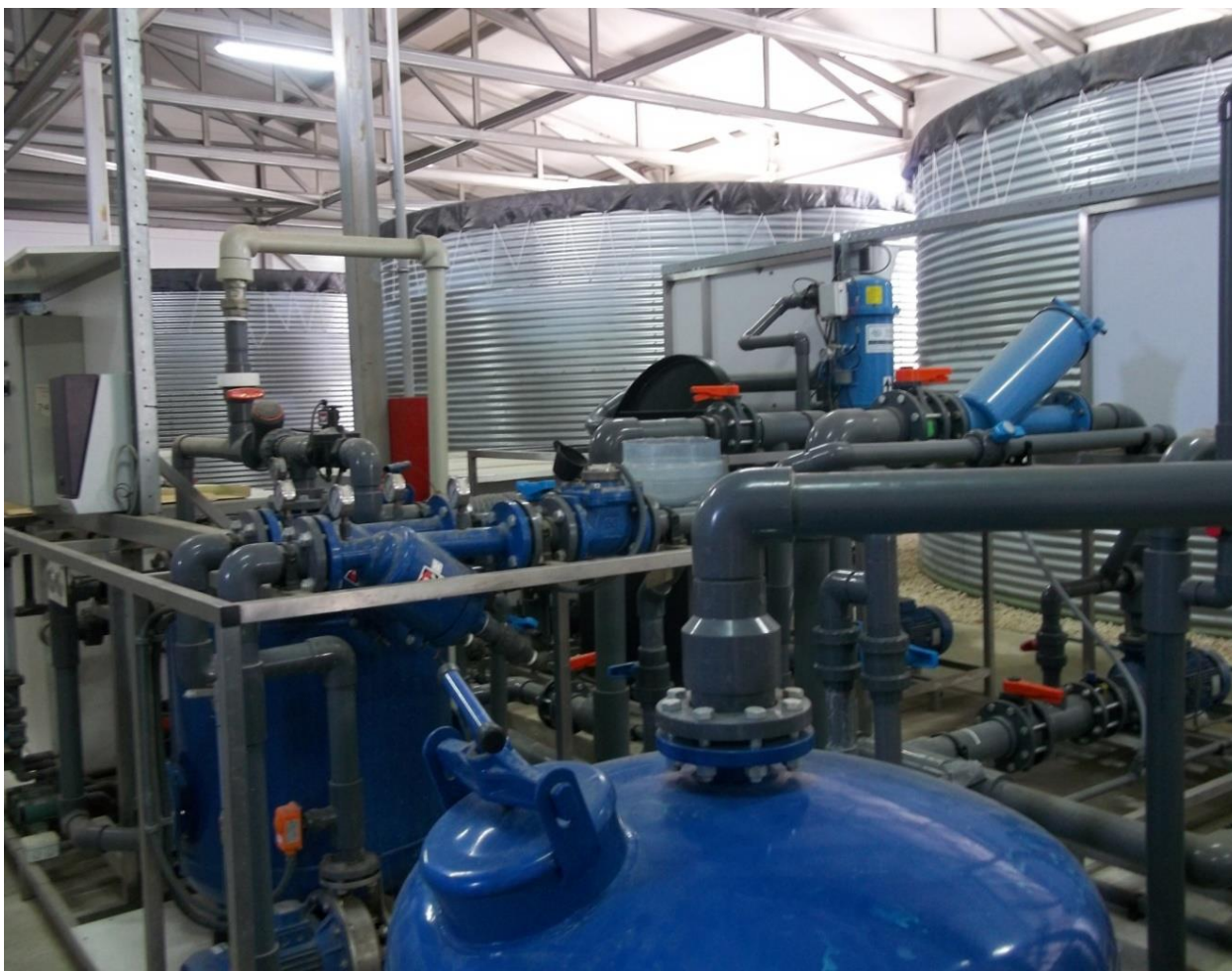
Рисунок 2.3 – Внешний вид растворного узла системы капельного полива FD-326D
