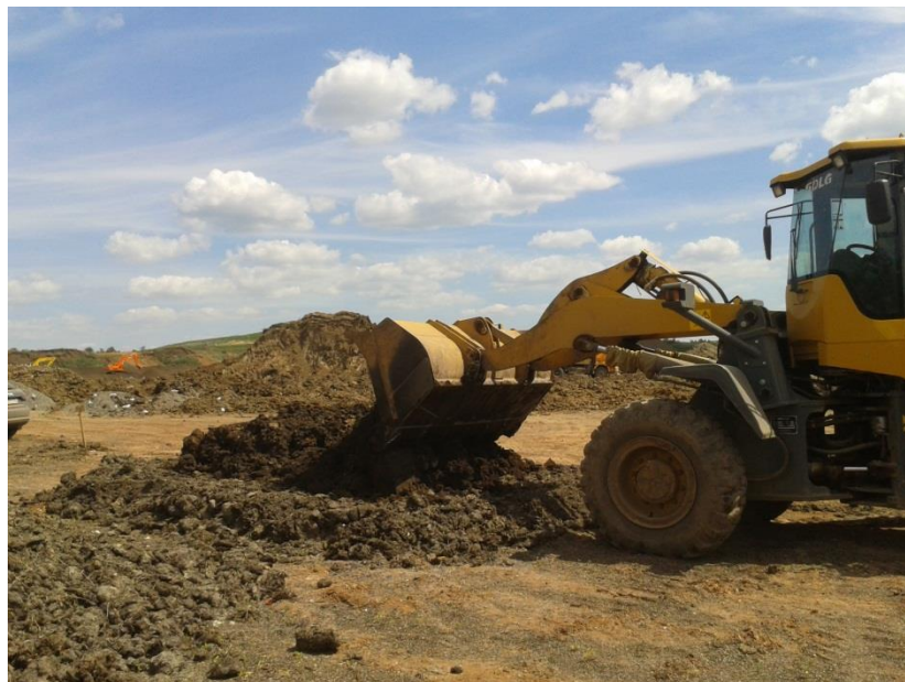
Рисунок 3.2 – Перемешивание образованной массы с помощью спецтехники
