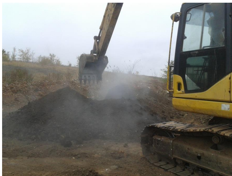
Рисунок 3.6 – Аэрирование буртов с помощью спецтехники
