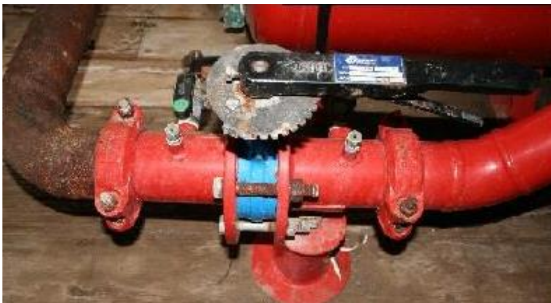
Рисунок 3.3 – Дисковая задвижка на узле подготовки удобрений
